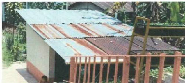
FOTO 2. CAMBIO DE TECHO SERVICIO SANITARIOS
