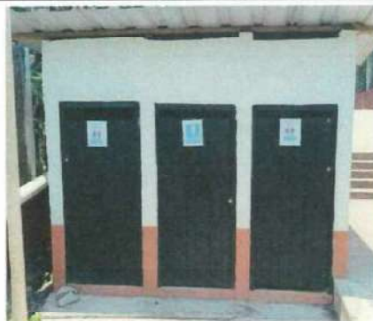
FOTO 4. SUSTITUCIÓN PUERTAS DE BAÑOS
