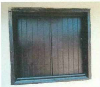
FOTO 5. SUSTITUCIÓN DE VENTANA DE MADERA
