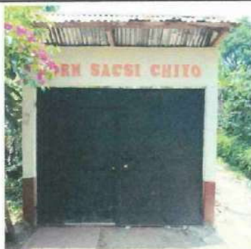
FOTO 3. MANTENIMIENTO A PORTONES
