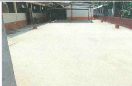
FOTO 8. SUSTITUCIÓN DE TORTA POR PISO CERAMICO
