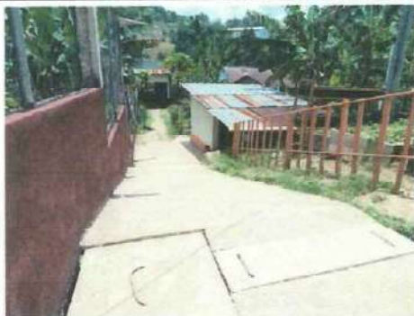
FOTO 1. INGRESO PRINCIPAL ENTECHADO
